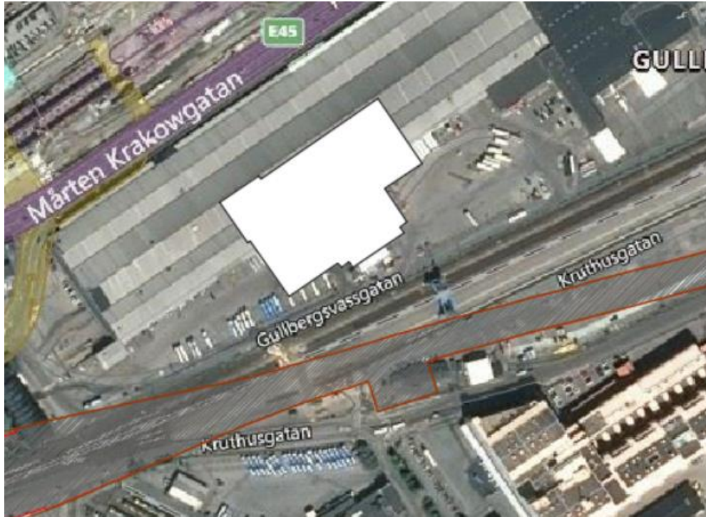
Figur 2 Det planerade byggnadsläget vid Gullbergsvass. Röd markering anger ungefärligt läge för Västlänken.
